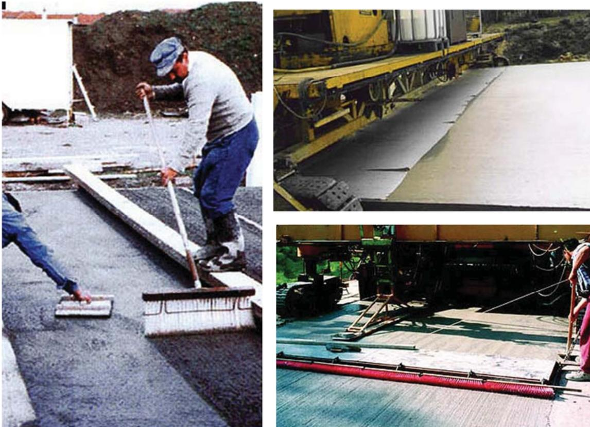
**Rys. 5.61 Przykłady wykańczania nawierzchni betonowej**
