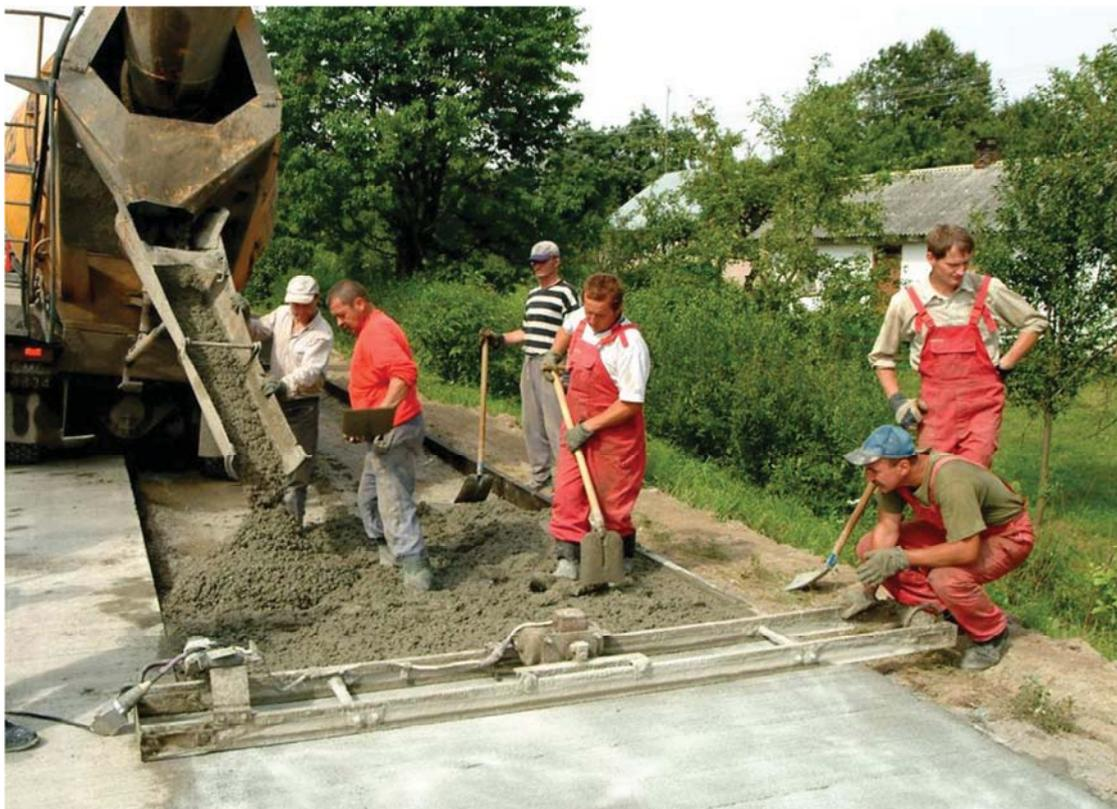
**Rys. 5.59 Układanie nawierzchni w deskowaniu stałym**
