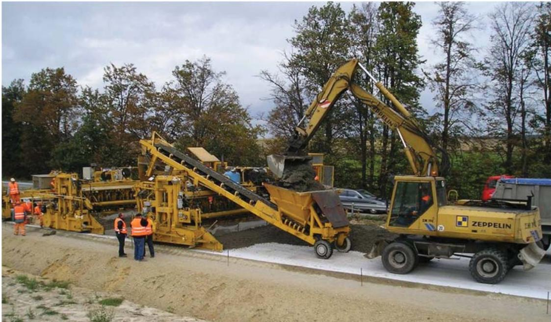
**Rys. 5.58 Zestaw maszyn w układaniu ślizgowym**
