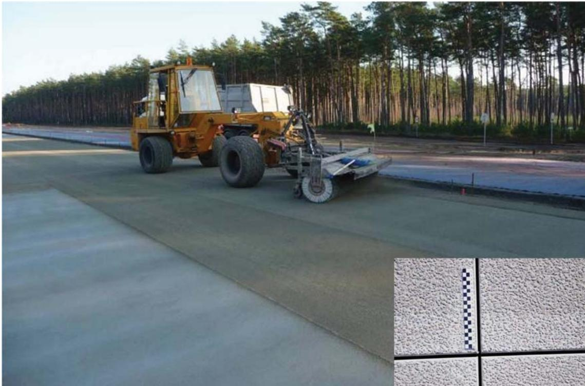
Rys. 5.62 Technologia eksponowania kruszywa
