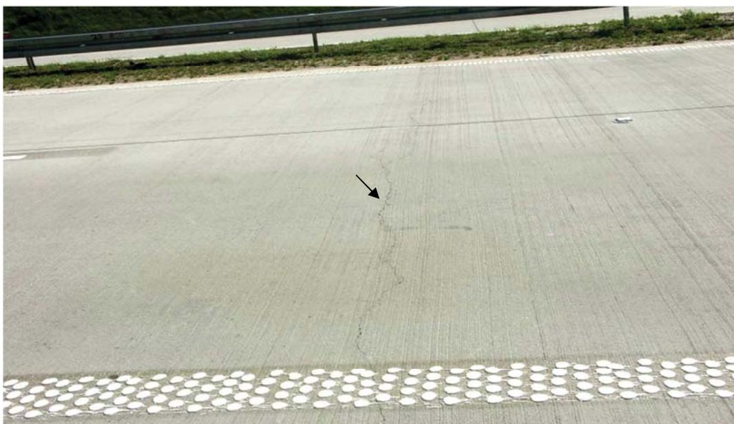
**Rys. 5.20 Szczelina skurczowa w nawierzchni o ciągłym zbrojeniu**
