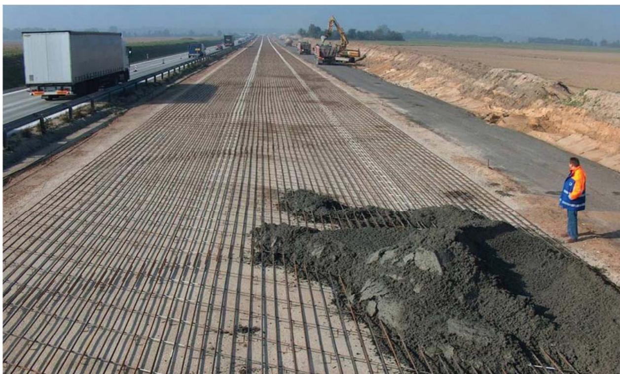
**Rys. 5.25 Układ zbrojenia przy budowie autostrady A4**
